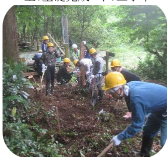
森の駅基礎工事 上:基礎完成 下:工事中
