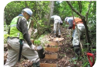
金屋幻の滝 階段整備
